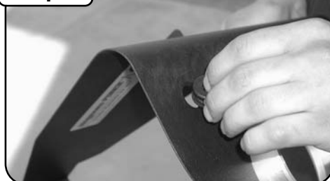
Insert rubber grommet.
